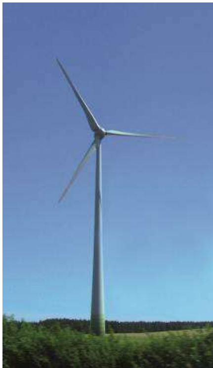
Kuva 3-4 Kuva lieriötornirakenteisesta tuulivoimalasta.
