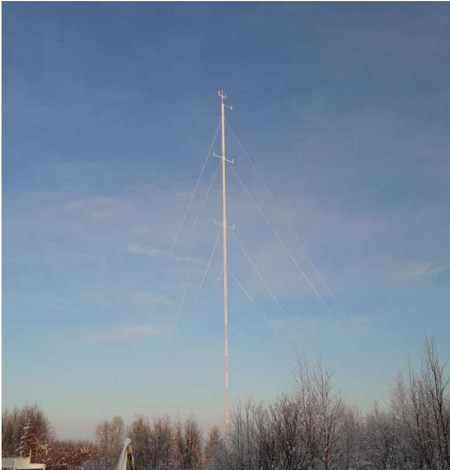
Kuva 4-12 Hankealueelle tammikuussa 2021 asennettu tuulenmittausmasto
