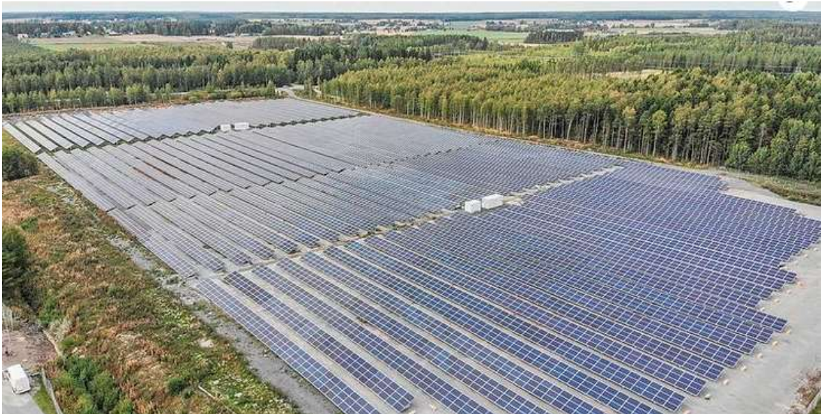
Kuva 3-7 Esimerkkikuva aurinkopuistosta. (Kuva: Solarigo Systems Oy)
