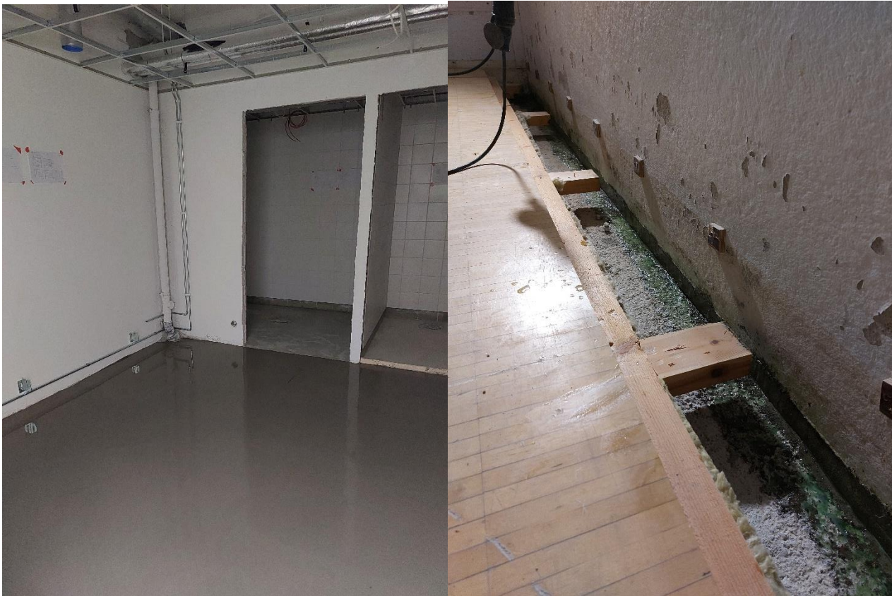
Lattioita oikaistu akryylitöitä varten
