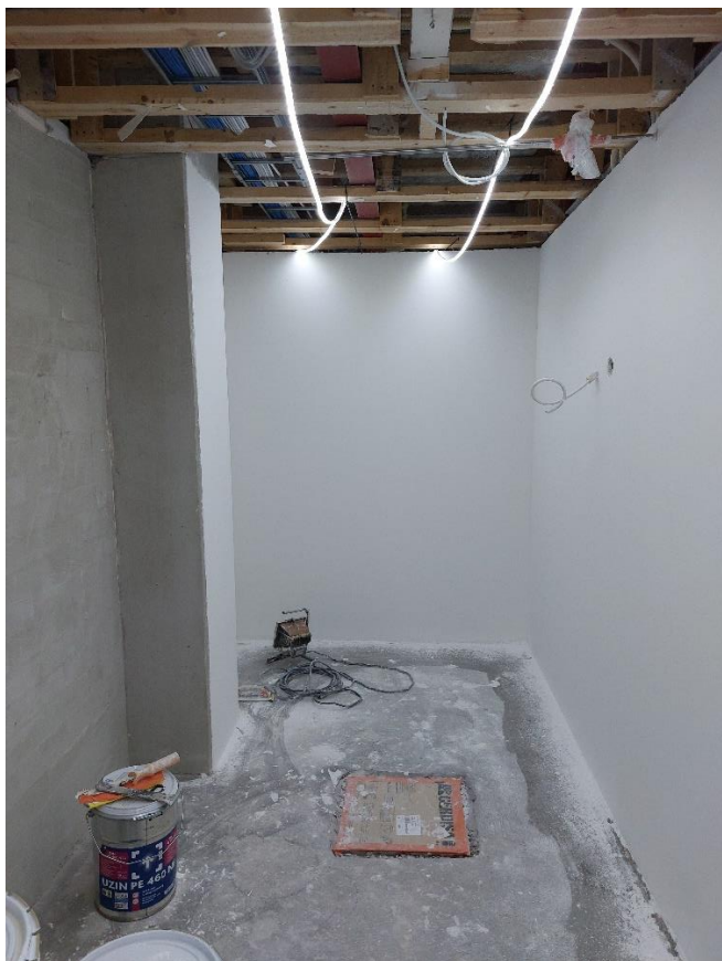
Yläkerran seinät tasoitettu
