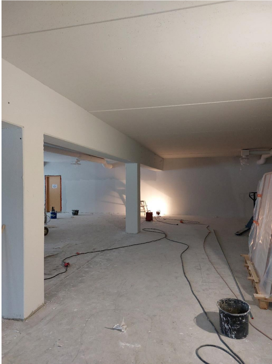
Kuntosalin väliseinien tasoitustyöt on aloitettu
