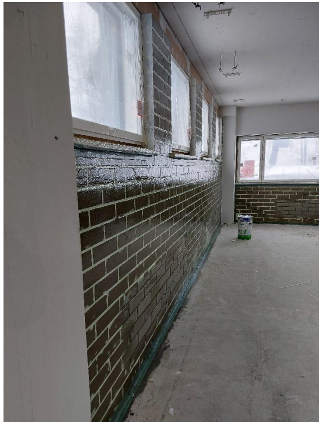
Kuntosalin seinät on kapseloitu
