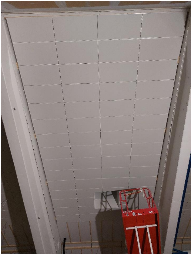
Liikuntasalin katon akustiikkalevyn asennus on 90% valmis
