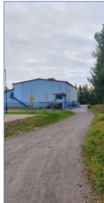
Kuva 11. Kevyen liikenteen reitti Kõlsänpuron itäpuolella.
