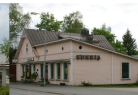
Huhtasen 1930-40-luvulla rakennettu laajennus on lapekattoinen.
